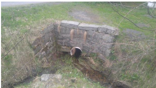
Obr. 5: L12 – vtok do zatrubnění DN 380
